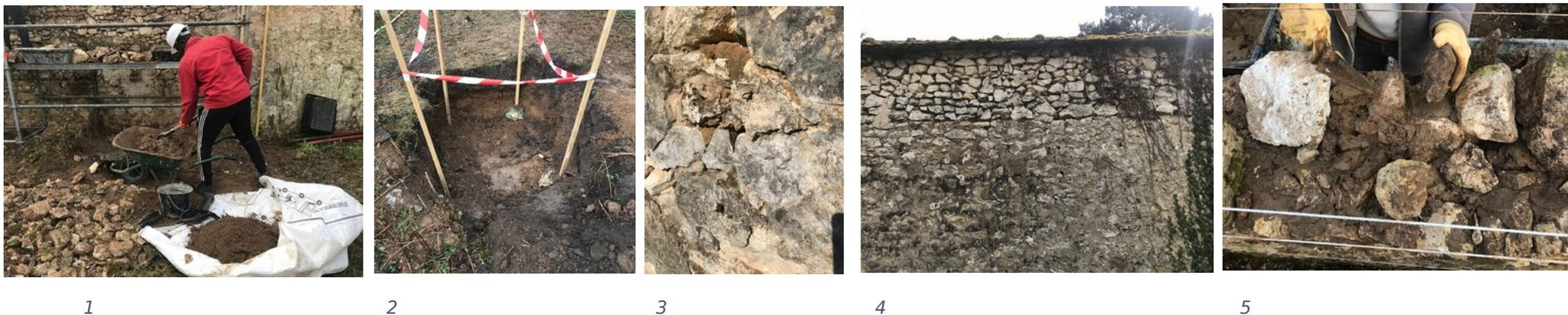
Figure 1 Réutilisation des pierres et de la terre du mur déposé
